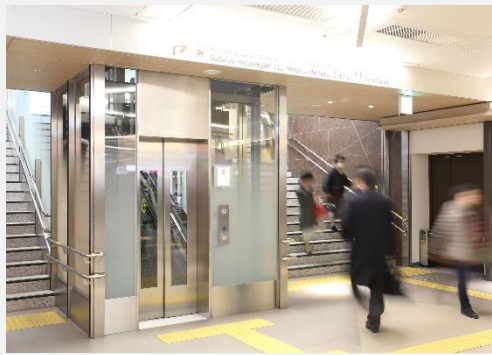
斜行エレベーター (北エリア 東山線連絡階段)
