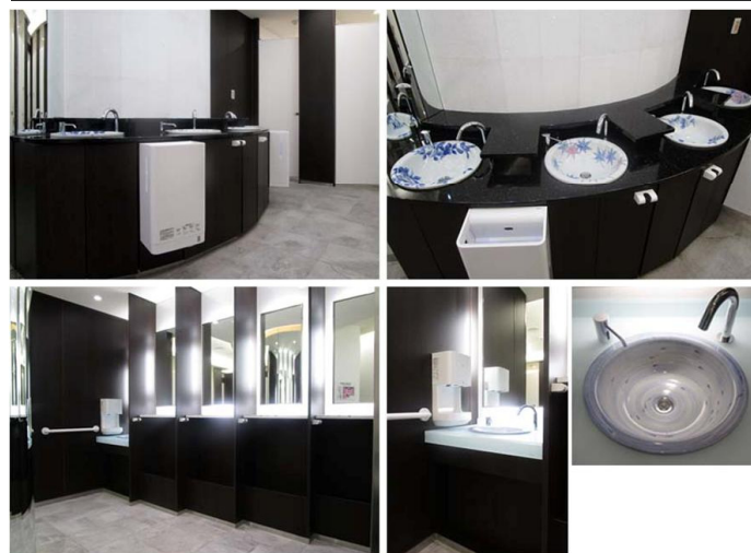
(写真上段)地元：瀬戸焼の洗面ボウルが設置された洗面コーナー。(写真下段左)隣からの視線を気にせず化粧直しができるように配慮し、間仕切りを設けたパウダーコーナー。
