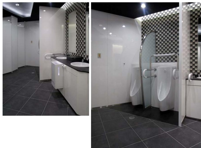
小便器コーナーは、隣を気にせず利用できるよう間仕切りを設置。汚れやすい小便器まわりの清掃性に配慮し、前面板・床面には防汚・防臭機能のある機能性タイル：ハイドロセラを採用。
